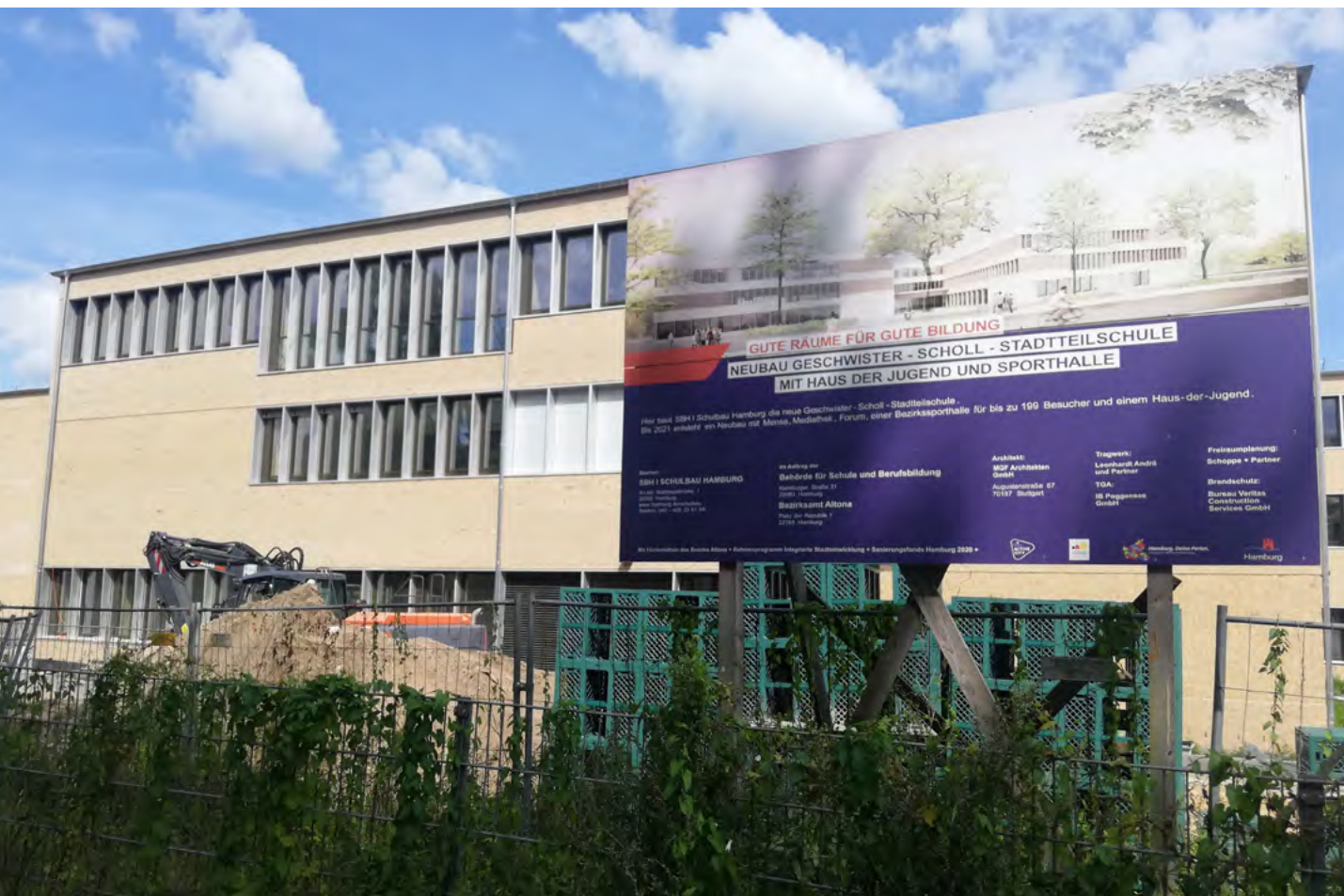
Im Bau Geschwister-Scholl-Stadtteilschule. RISE fördert Tribüne der Sporthalle und Schulgelände
