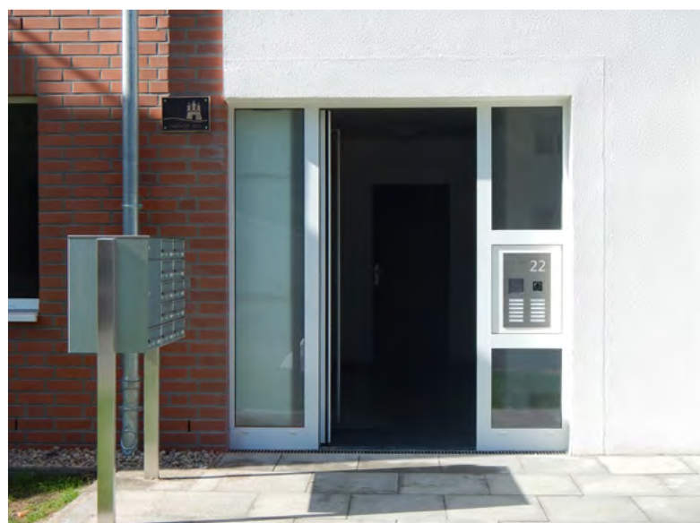
Eingang Haus B
